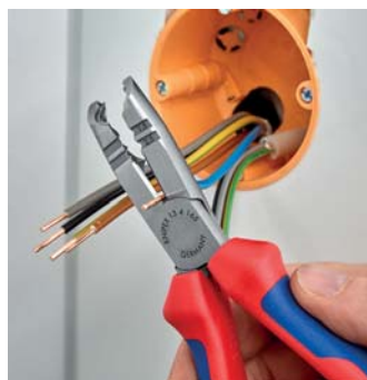
Řezání při zkracování jednotlivých vodičů
